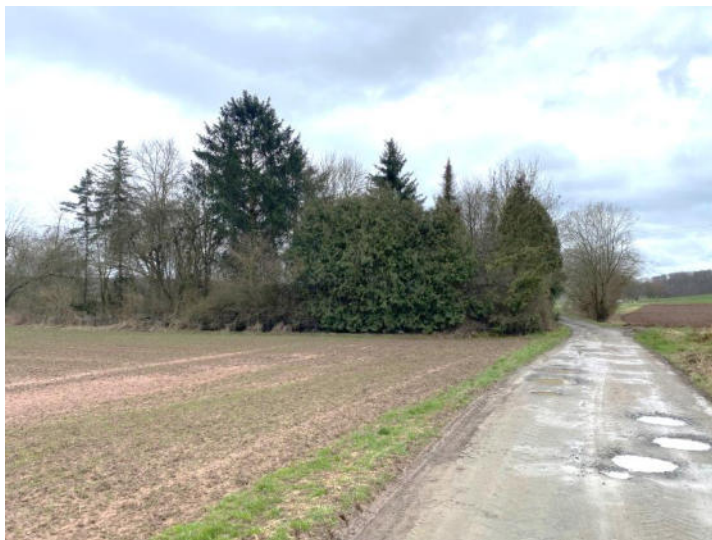
Foto 2: Schotterabschnitt der Straße „Am Bürgerhaus“
