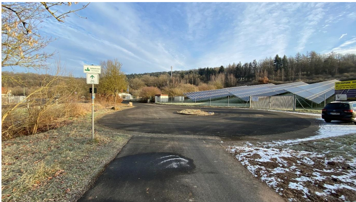
Blick nach Norden in den Wendehammer im GE „In der Breit“
