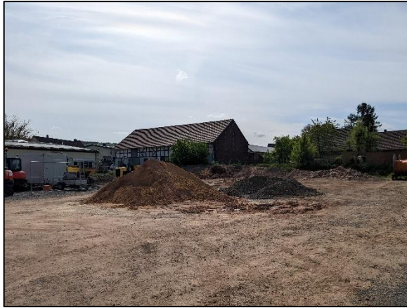
Abb. 18: Baustelle im südöstlichen Bereich des Plangebietes (eigene Aufnahme, 05/2025)
