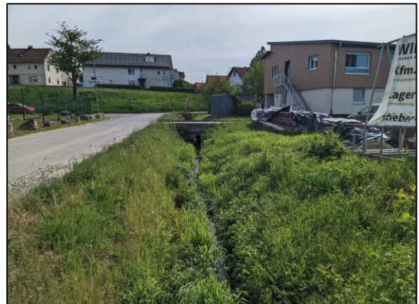
Abb. 23: Gewässerverlauf des Scheerbachs mit Blick von Westen nach Osten auf die östlich im Plangebiet gelegene Brücke (05/2025)
