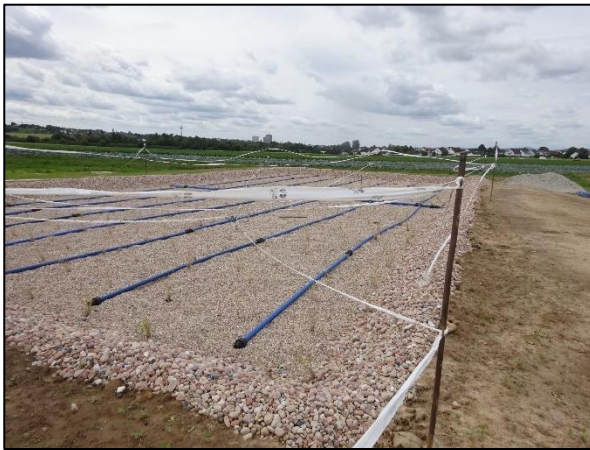
Abb. 12: Pflanzenkläranlage im Aufbau
