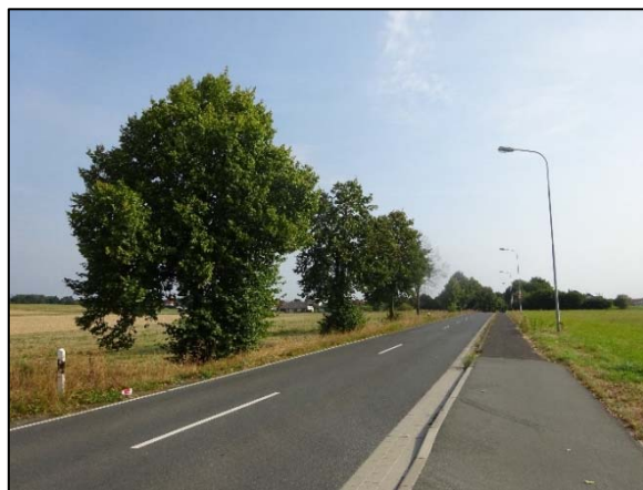
Abb. 19: Gießener Straße (K 355) mit angrenzenden Laubbäumen (eigene Aufnahme 08/2024).
