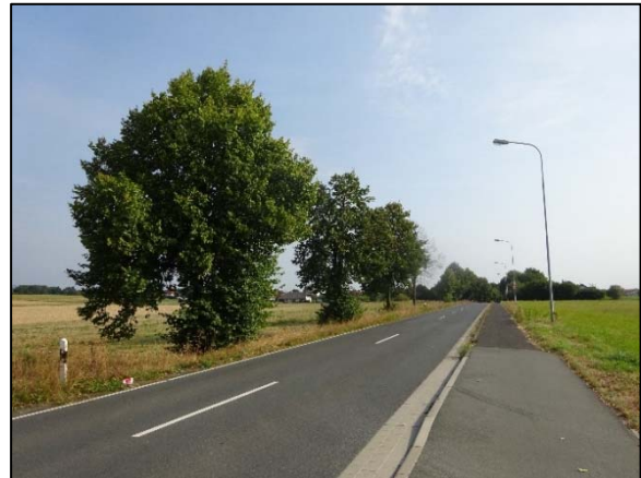
Abb. 23: Gießener Straße (K 355) mit angrenzenden Laubbäumen (eigene Aufnahme 08/2024).
