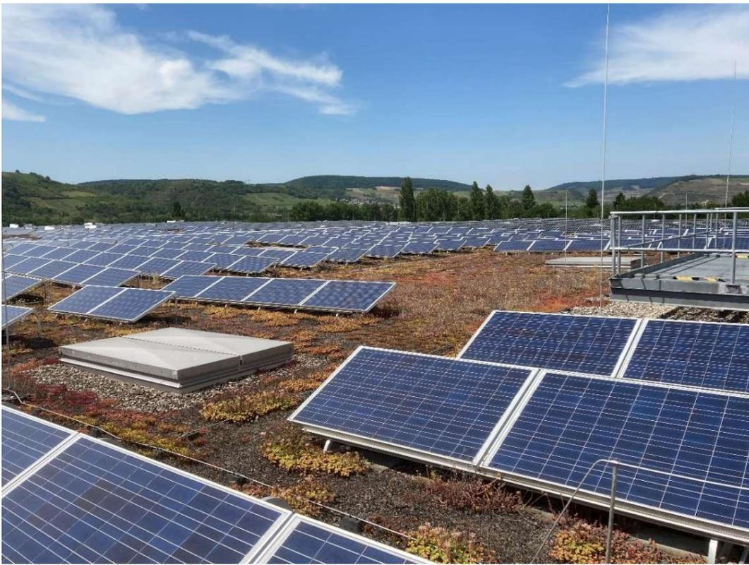
**Foto 2:** Beispielhafte Darstellung einer extensiven Dachbegrünung in Kombination mit PV-Anlagen (Fotoaufnahme: ÖKOPLANA)
