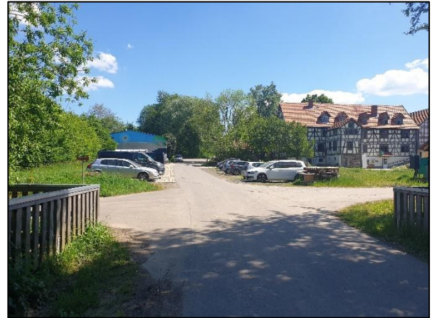
Abb. 43: Vorgesehene Fläche für das Sondergebiet 9 entlang der Straße Melchiorsgrund
