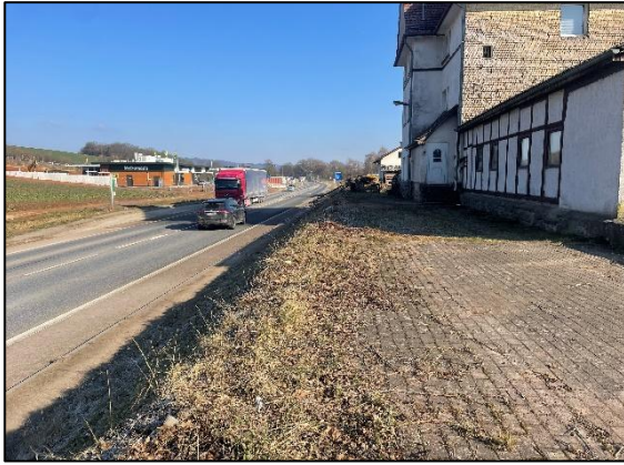
Abb. 15: Gepflasterte Bereich im Nordwesten des Plangebietes (eigene Aufnahme 02/2025)
