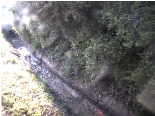
vorhandenes Grabenprofil L3433 – Höhe Moorstraße „Graben Am Stein“
