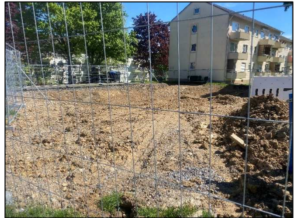
Offener Boden im Bereich des abgerissenen Gebäudes
