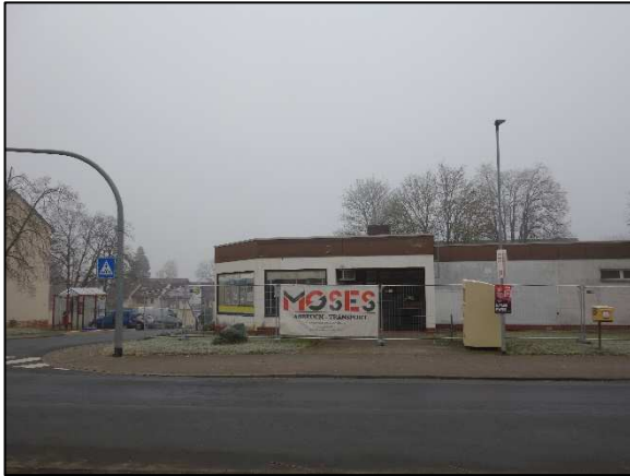
Ehemaliges Gebäude an der Ecke Mozartstraße und Pohlkönser Straße
