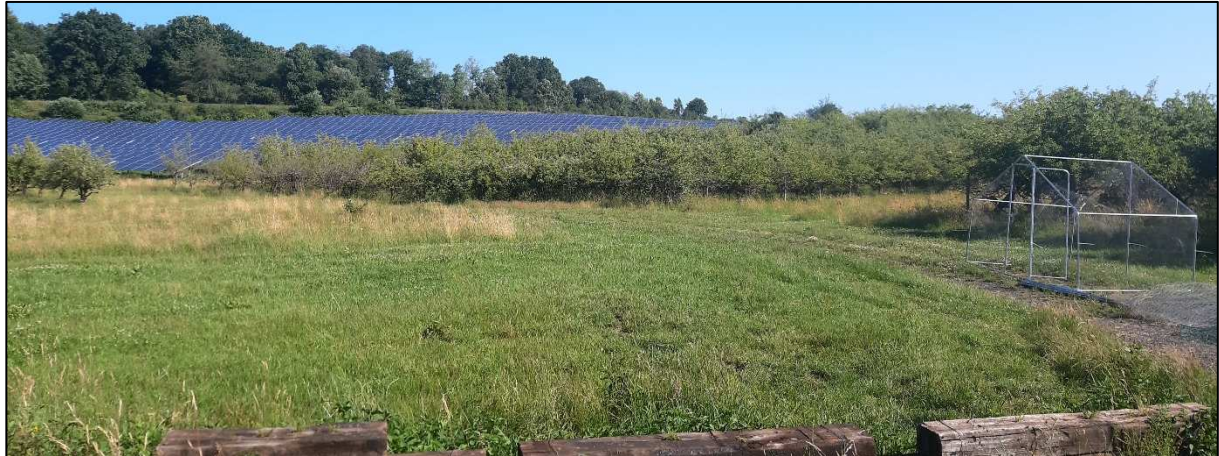
Abb. 16: Blick auf den bestehenden Solarpark, der an das Plangebiet angrenzt (eig. Aufnahme 06/2025).
