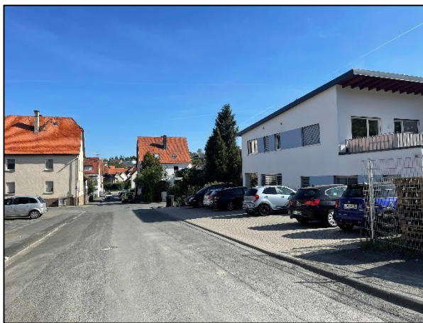
Abb. 15: Bahnstraße sowie bebaute Grundstücke im nördlichen Teilbereich des Plangebietes (Aufnahme 04/2025).
