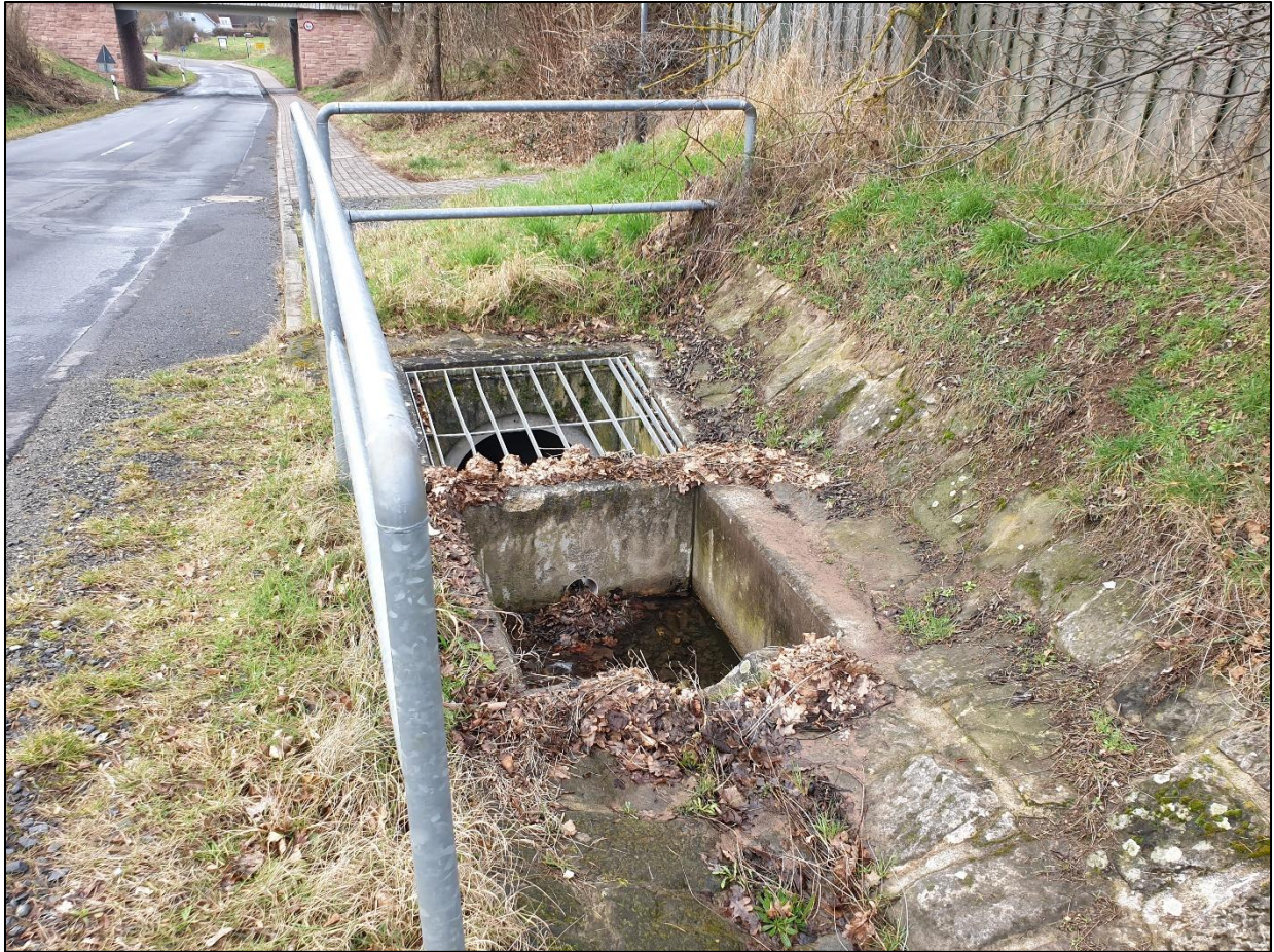
Abb. 7: Einlaufbauwerk am Hardbach nördlich der Stoppeler Straße
