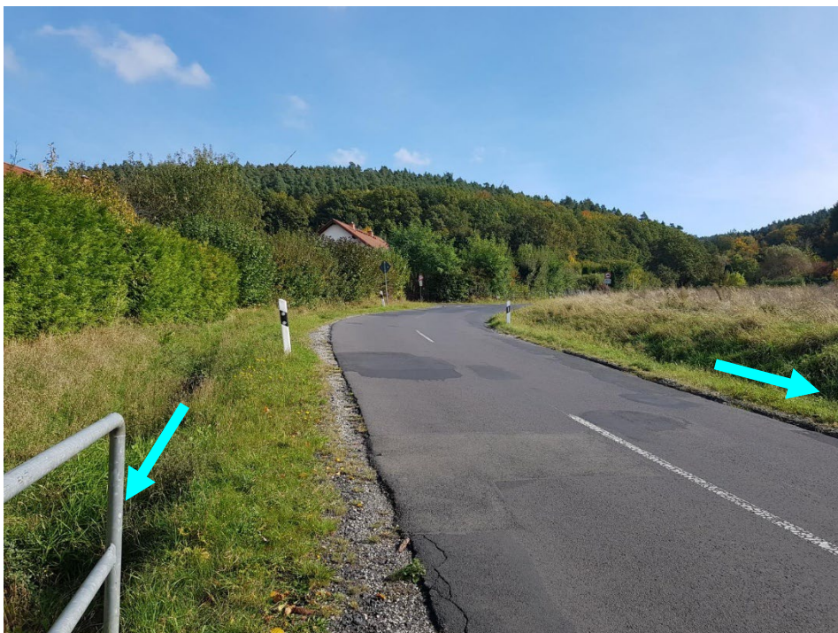
Abbildung 5: Foto 2 | "Stoppeler Straße" (L3431) | Entwässerungsgräben
