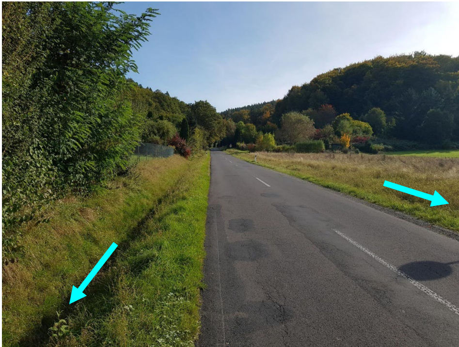
Abbildung 4: Foto 1 | "Stoppeler Straße" (L3431) | Entwässerungsgräben
