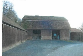
Feldscheune, Ansicht von Norden (Foto: Benak, LfDH)
