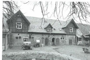
Hofgut Friedelhausen, nordwestliche Wirtschaftsgebäude
