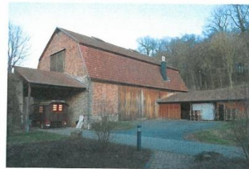
Feldscheune, Ansicht von Südwesten (Foto: Benak, LfDH)
