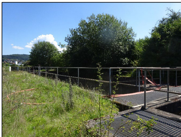
Abb. 5: Blick von Nordwesten in den Bereich der Regenrückhaltebecken.
