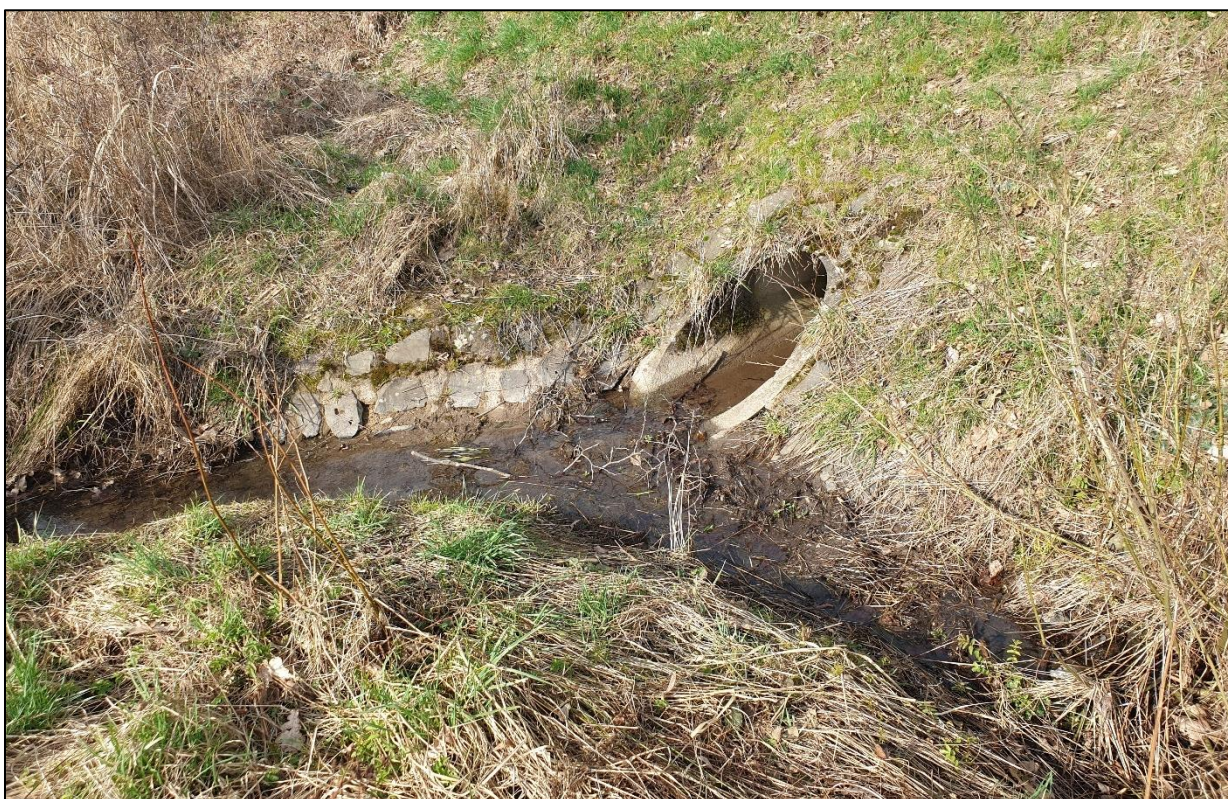
Abb. 21: Verrohrung unter der Landstraße (Jahr 2024)
