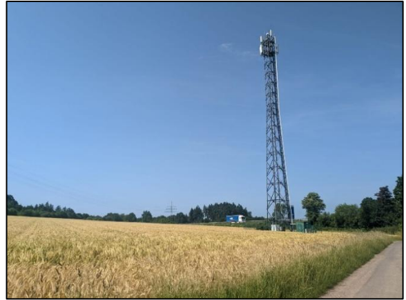
Abb. 6: Funkmast (Blickrichtung Westen)
