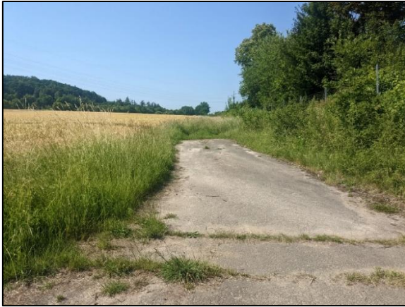
Abb. 5: Teilausgebauter Lw. Weg
