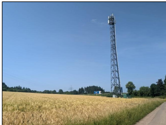
Abb. 6: Funkmast (Blickrichtung Westen)
