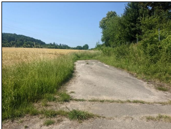
Abb. 5: Teilausgebauter Lw. Weg
