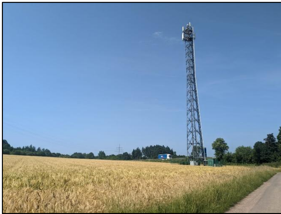
Abb. 7: Blick von Osten nach Westen auf das Plangebiet (eigene Aufnahme, 06/2025)
