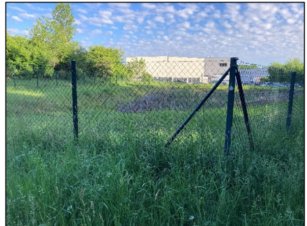
Abb. 20: Regenrückhaltebecken mit Umzäunung (eigene Aufnahme 05/2025).
