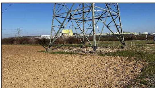
Abb. 13: Strommast im Südöstlichen Randbereich. Eigene Aufnahme 03/2025.
