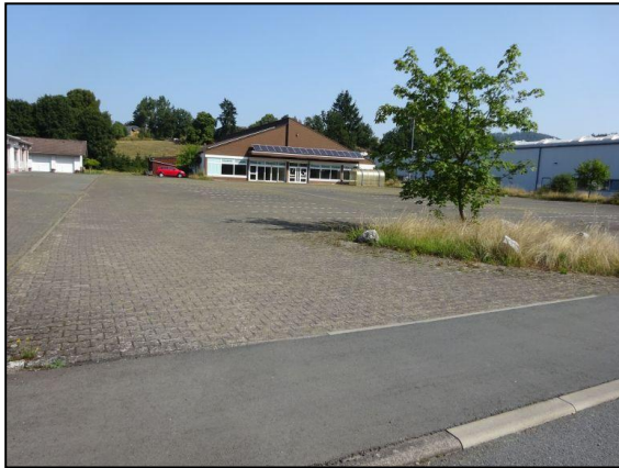
Abb. 5: Geltungsbereich von der Straße „Oberau“, Blick nach Norden.
