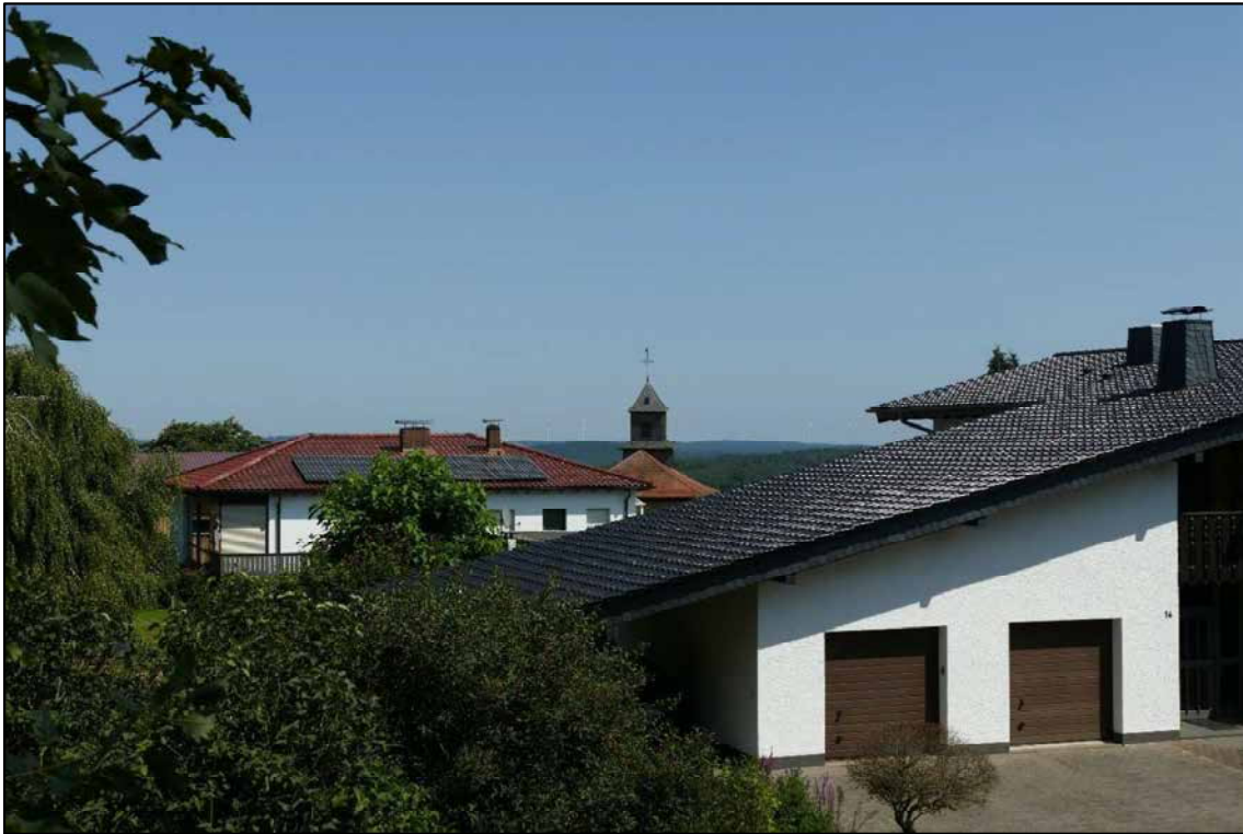
Abbildung 20: Kirche Burgholz, Ansicht von Südwesten
