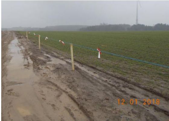
Abbildung 7: Beispiel einer zu spät errichteten Baufeldbegrenzung mittels Pfosten, Spannschnur und Flutterband
