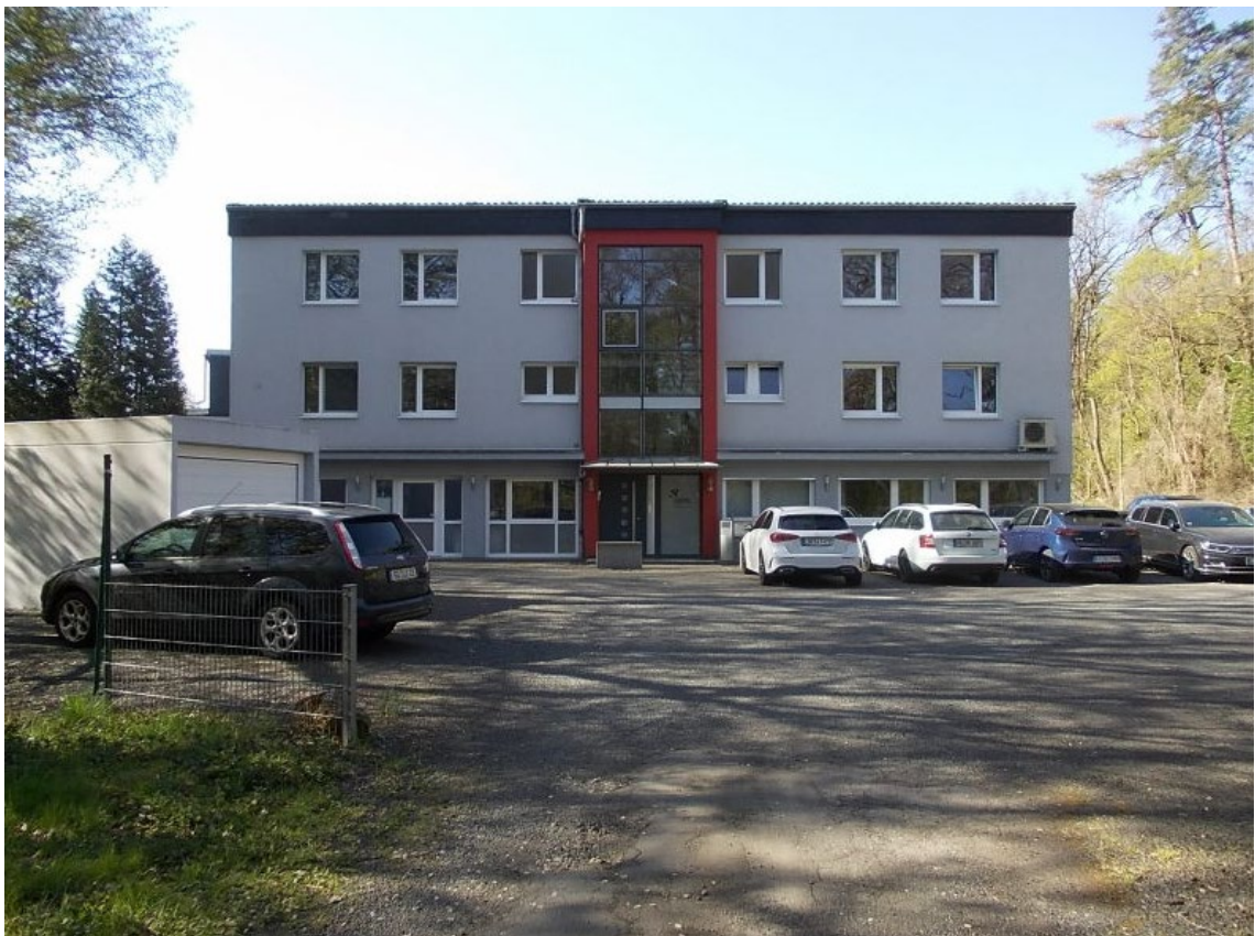
Abbildung 7: Hauptgebäude und Fertiggaragen, Am Bergwerksfeld 2
