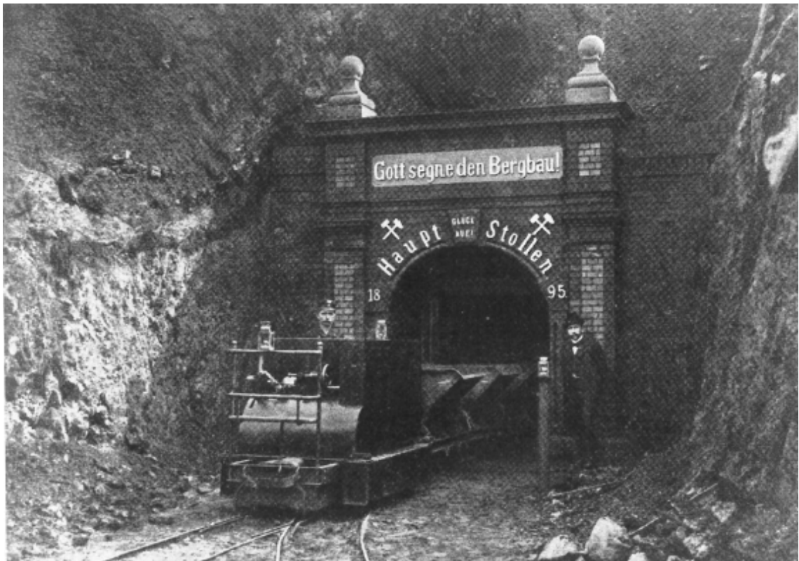
Abbildung 2: Grubenbahn bei der Ausfahrt aus dem Hauptstollenportal in Betrieb 8 [7]
