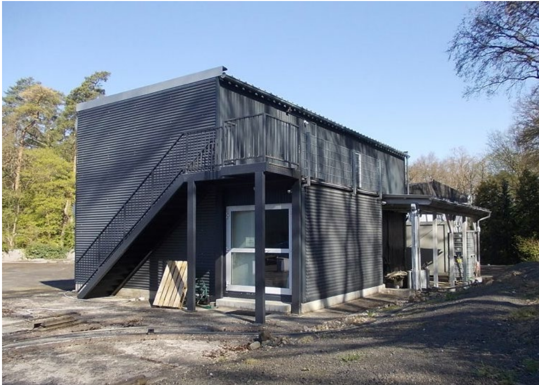
Abbildung 9: 13 Raumzellen als Lagercontainergebäude, Am Bergwerksfeld 2
