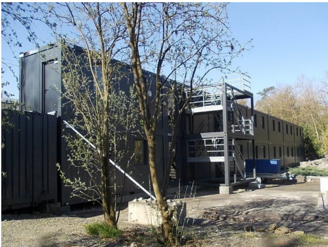
Abbildung 10: 15 Raumzellen als Lagercontainergebäude, Grundstück Am Bergwerksfeld 2
