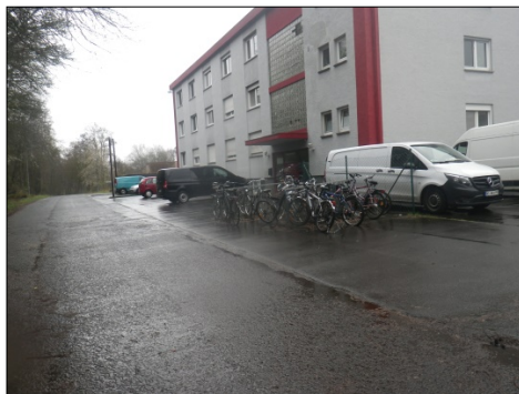
Foto 7: Straße Am Bergwerkswald mit Stiftungsgebäude
