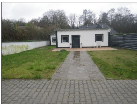
Foto 3: Bungalow mit Blickrichtung Westen
