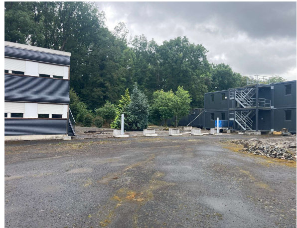
Foto 2: Zentraler, asphaltierter Bereich mit umgebauter Halle und Betonfläche
