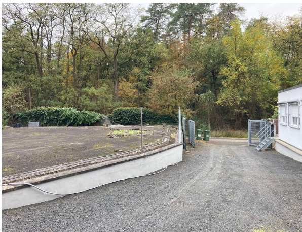
Foto 4: Westliche Grundstückszufahrt mit Lage der GW-Messstelle U2
