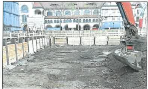
Abb. 4. Schichtenweiser Abtrag, verpflichtend bei baubegleitender KMR
