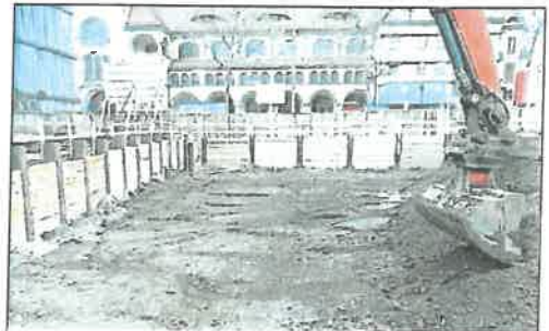
Abb. 4. Schichtenweiser Abtrag, verpflichtend bei baubegleitender KMR
