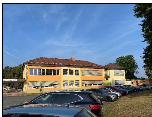
Abb. 5: Parksituation, Blickrichtung Westen
