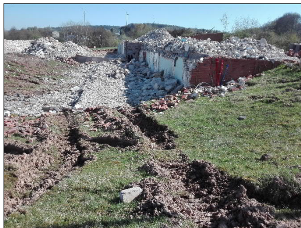
Abb. 8: Zum Teil abgerissene Gebäude und randliche Reste von Wiesenflächen (eigene Aufnahme, 04/2018)
