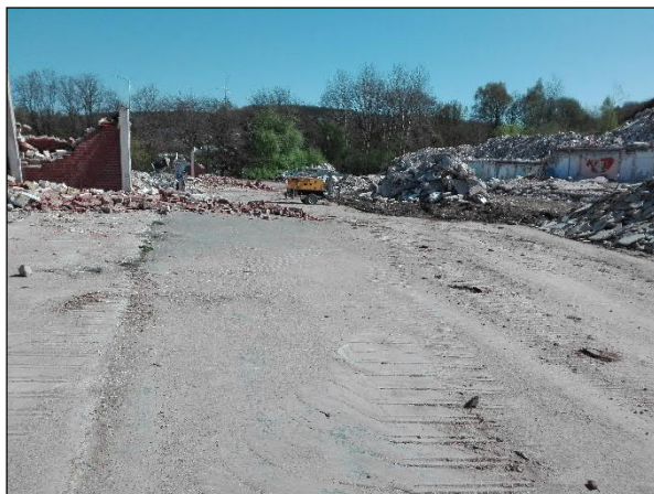
Abb 7: Blick über einen Bereich, auf dem Abbrucharbeiten stattgefunden haben (eigene Aufnahme, 04/2018)
