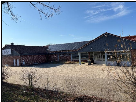
Abb. 7: Gewerbefläche mit Bestandsgebäude und gepflasterten Stellplatzflächen. (eigene Aufnahme, 03/2026)
