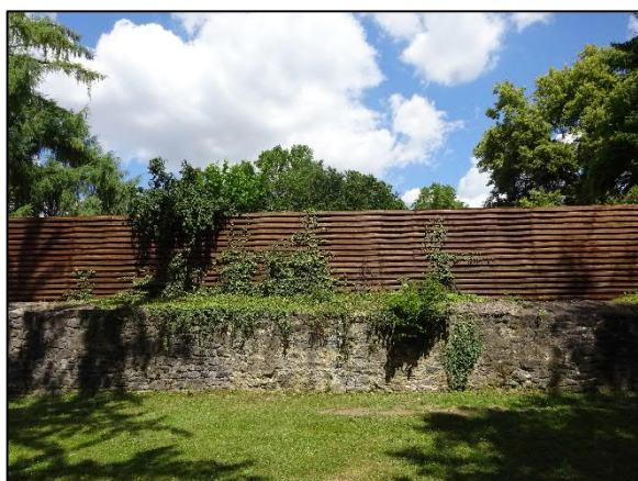
Abb. 9: Bewachsene Mauer im südlichen Randbereich des Plangebietes (eigene Aufnahme 07/2025).
