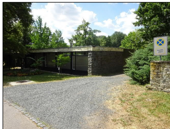
Abb. 8: Blick auf die Lesehalle und den Schotterweg im Osten des Plangebietes (eigene Aufnahme 07/2025).
