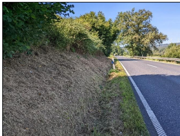
Abb. 6: Ausgetrockneter Graben zwischen L3199 und Gehölzstrukturen mit Blick von Osten nach Westen (08/2024)
