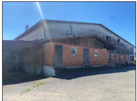
Abb. 14: Versiegelte Flächen (Asphalt) und Gebäude im Norden des Plangebietes (eigene Aufnahme 30.04.2025)
