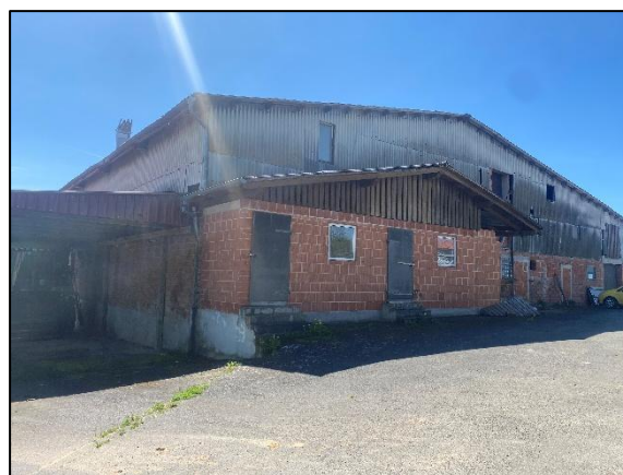
Abb. 14: Versiegelte Flächen (Asphalt) und Gebäude im Norden des Plangebietes (eigene Aufnahme 30.04.2025)
