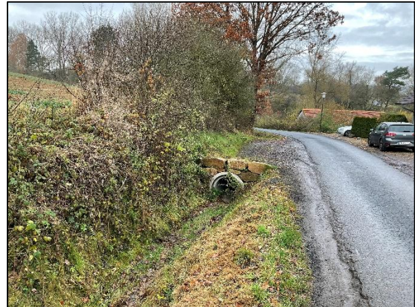
Abb. 6: Ein Teilabschnitt des nördlich verlaufenden Grabens ist verrohrt und mit einer Schotterfläche versehen.
