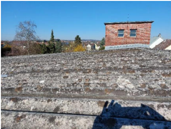
Wellasbestdach Halle H
