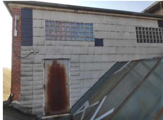
Fassadenplatten aus Asbestzement Dachaufsatz Halle I
