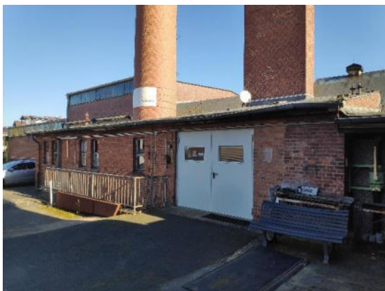
Pot. asbesthaltige Brandschutztür, Halle I
