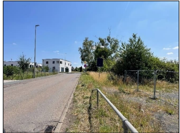
Abb. 19: Faulbacher Straße sowie Straßenbegleitgrün (eigene Aufnahme 06/2025)
