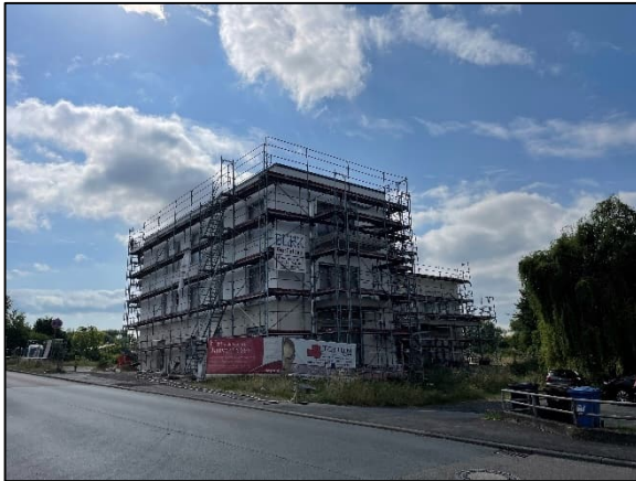
Abb. 18: Gebäude im nordwestlichen Abschnitt des Plangebietes (eigene Aufnahme 06/2025)
