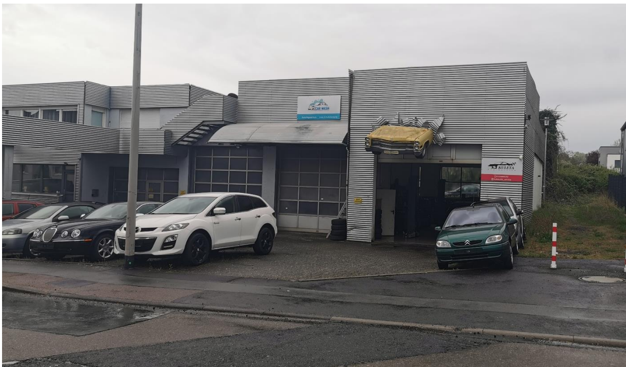
Abbildung 5: Ansicht der Kfz-Werkstatt, Seite zur Faulbacher Straße (Tor 1 – 4 von rechts nach links)
