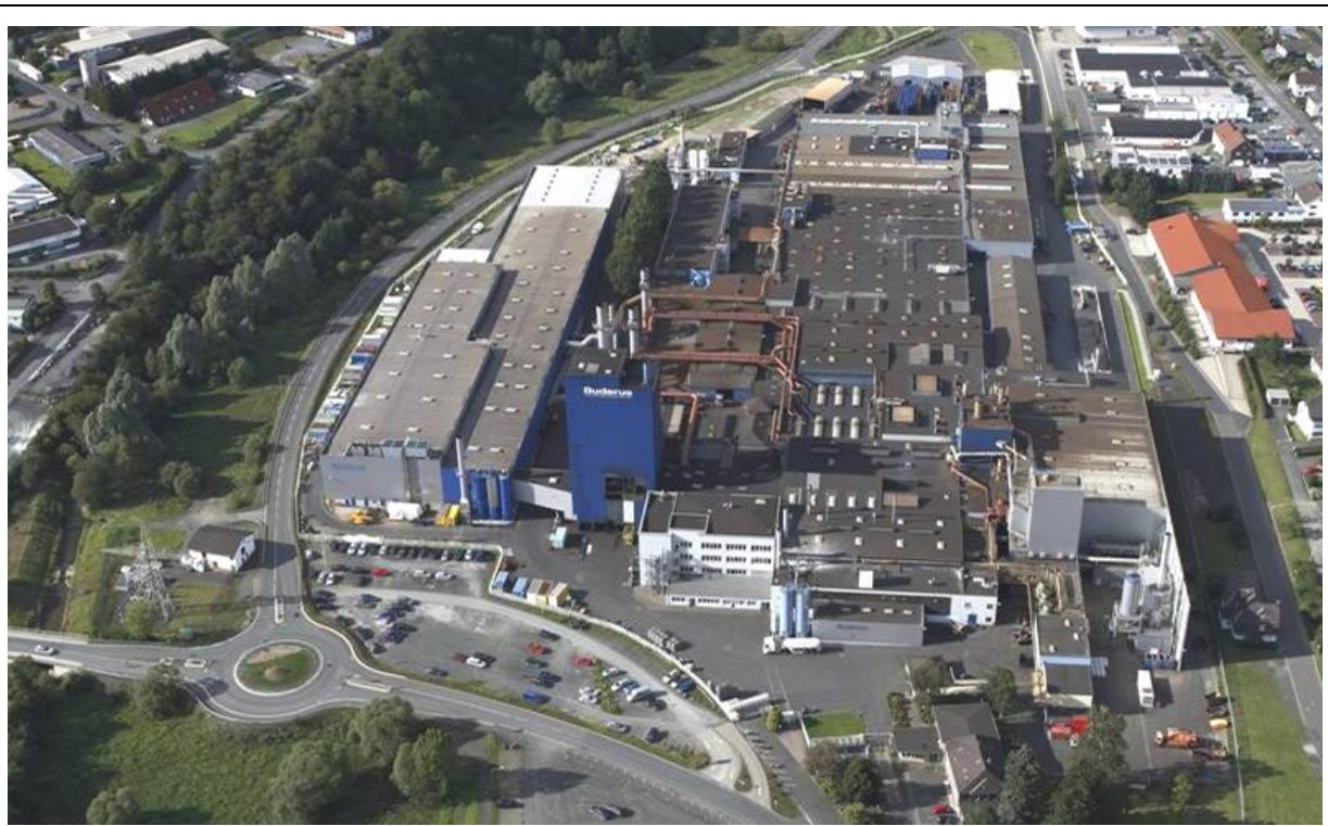
Abb.5: Übersicht Betriebsgelände (Breyden GmbH, ehemals Buderus Guss GmbH) in Breidenbach
