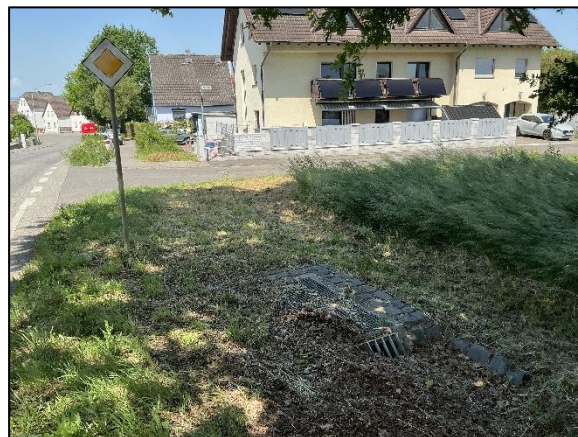
Foto 4: Blick auf den Grünstreifen, Entwässerungsgraben und Einlaufwerk sowie auf das Straßenbegleitgrün im Südwesten des Plangebietes (Zierarten) (eig. Aufnahme, 27.05.2026).
