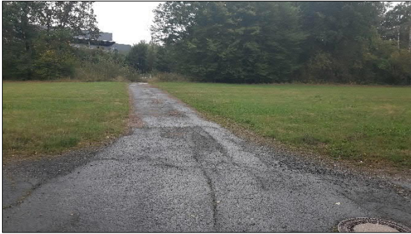
Abbildung 13: Asphaltierter Wirtschaftsweg mit unterirdischer Bachverrohrung, Blickrichtung Süd
