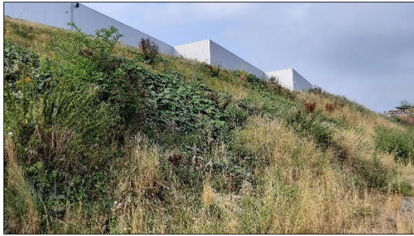
Abbildung 2: Böschung/ Hang im Nordosten
