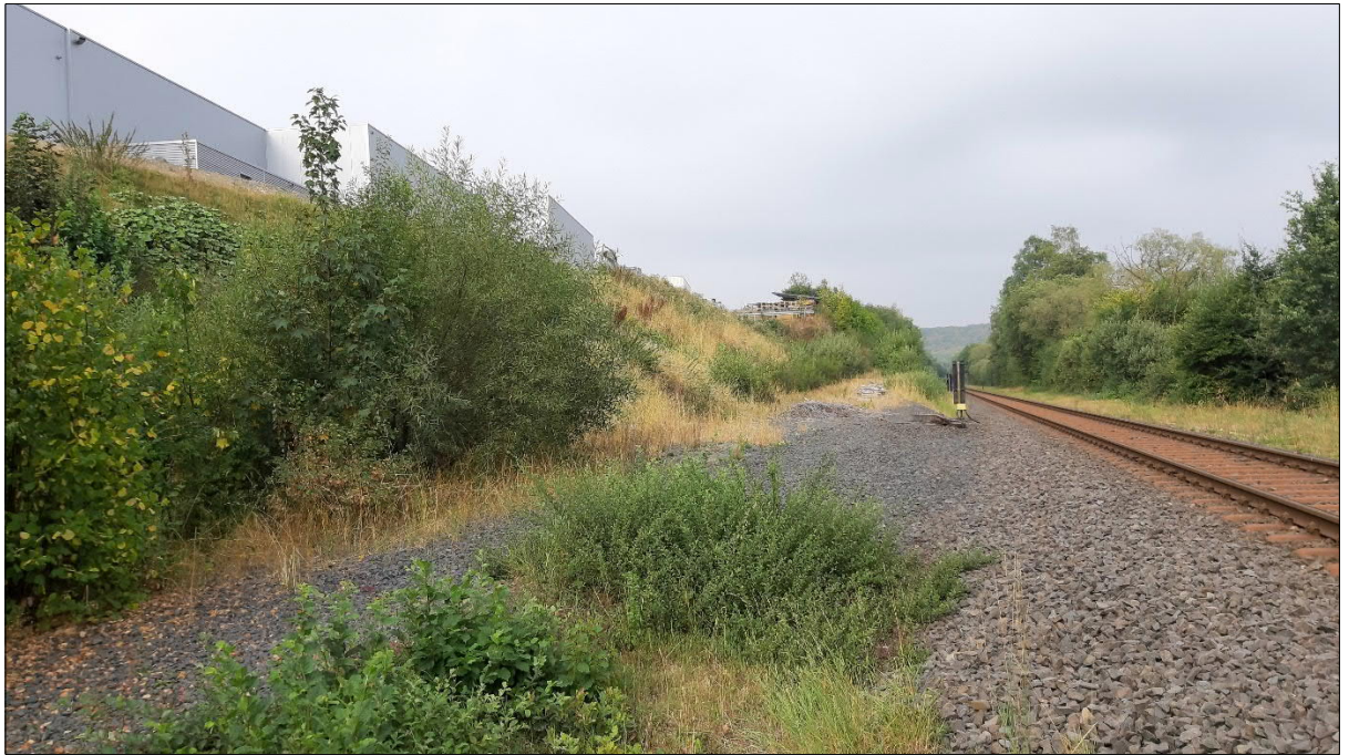
Abbildung 10: Blick von Osten auf das Plangebiet zwischen bestehender Bebauung und Hellertalbahn
