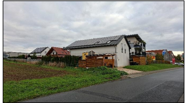
Abb. 11: Gebäudebestand im Südosten an der Gießener Straße (eigene Aufnahme 10/2025).
