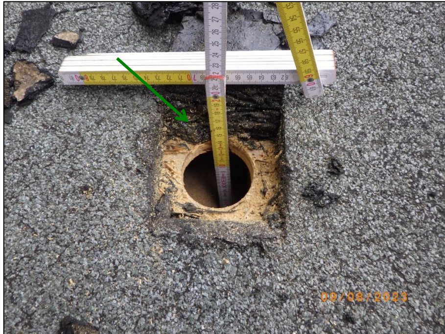
Foto 35 Werkstatt (37/10): Dachaufbau mit teerhaltiger Dachpappe (P 20 a/b) , exemplarisch
