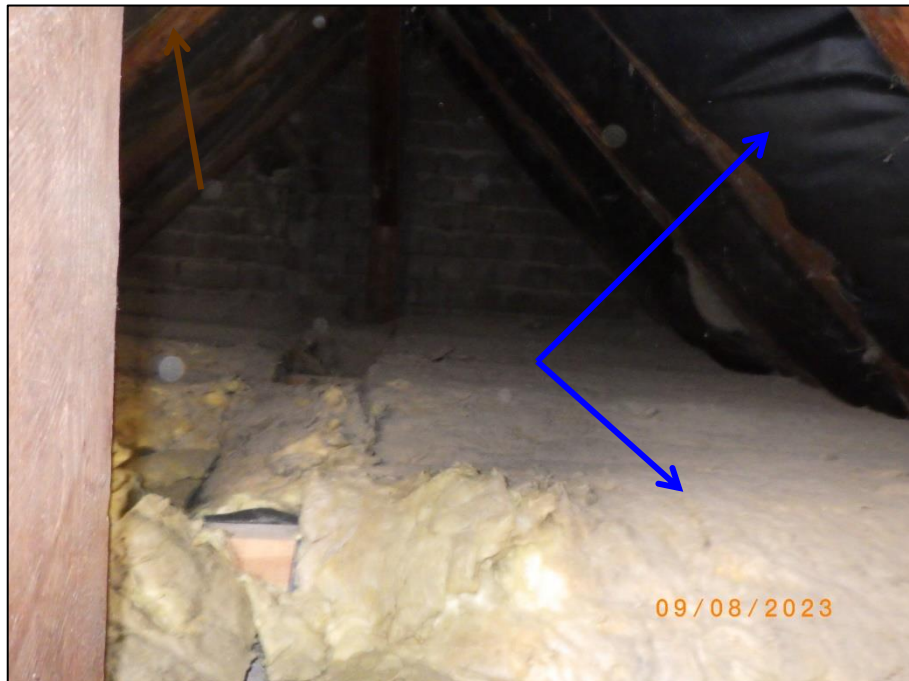
Foto 32 Werkstatt (37/11), Spitzboden: aufgelegte KMF-Dämmung sowie kaschierte KMF-Dachdämmung (P 19) , exemplarisch, A IV Holz Dachbalken
