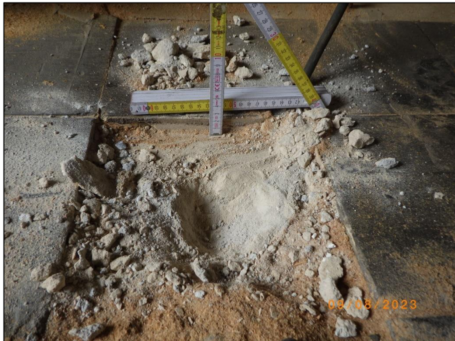
Foto 36 Werkstatt/Holzlager (37/15), EG: Fußbodenaufbau (KB 10), Gussasphalt P 22
