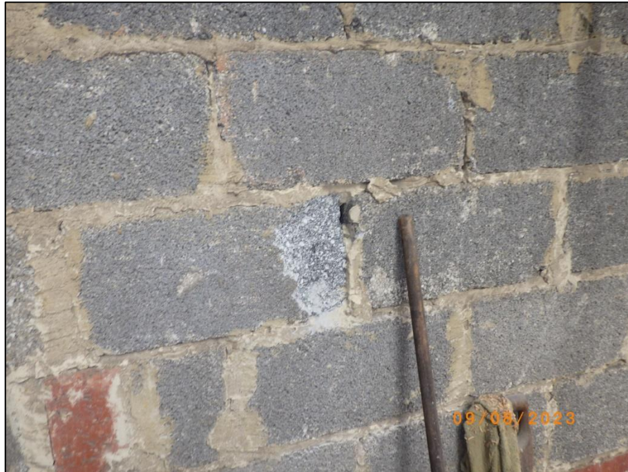
Foto 41 Werkstatt (37/7 + 9 + 10): Bimssteinmauerwerk (P 24.1)
