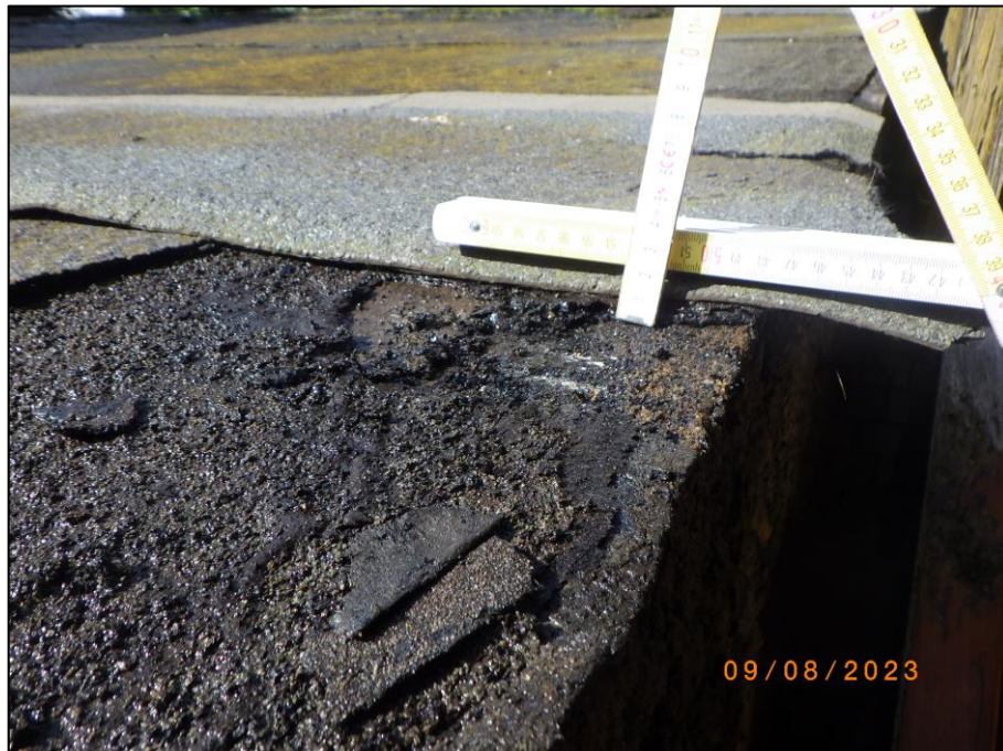
Foto 22 Carport (37/3): Dachaufbau, mit Dachpappe (P 12 a/b)
