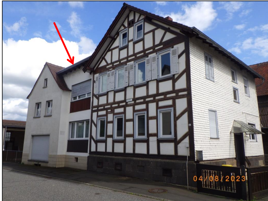
Foto 1 Außenansicht: Wohngebäude, Zwischenbau mit AZ-Schindeln und Büro und Verkaufsraum
