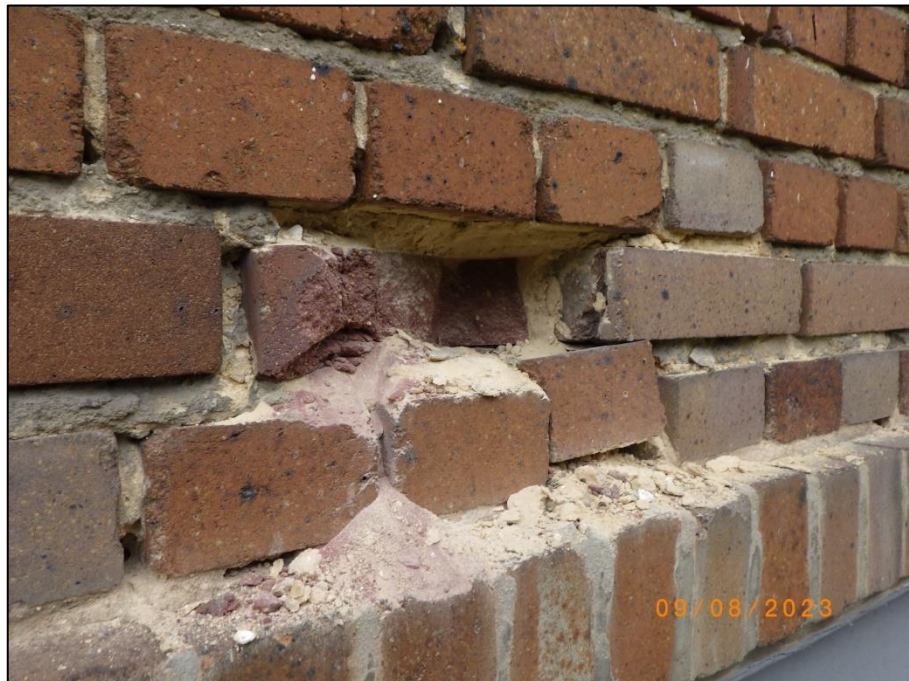
Foto 42 Werkstatt (37/7 + 9 + 10): Backsteinmauerwerk (P 24.4)
