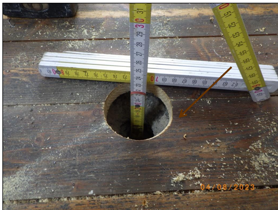
Foto 16 Büro (37/13), OG: Fußbodenaufbau (KB 6) mit A IV Holz Dielen
