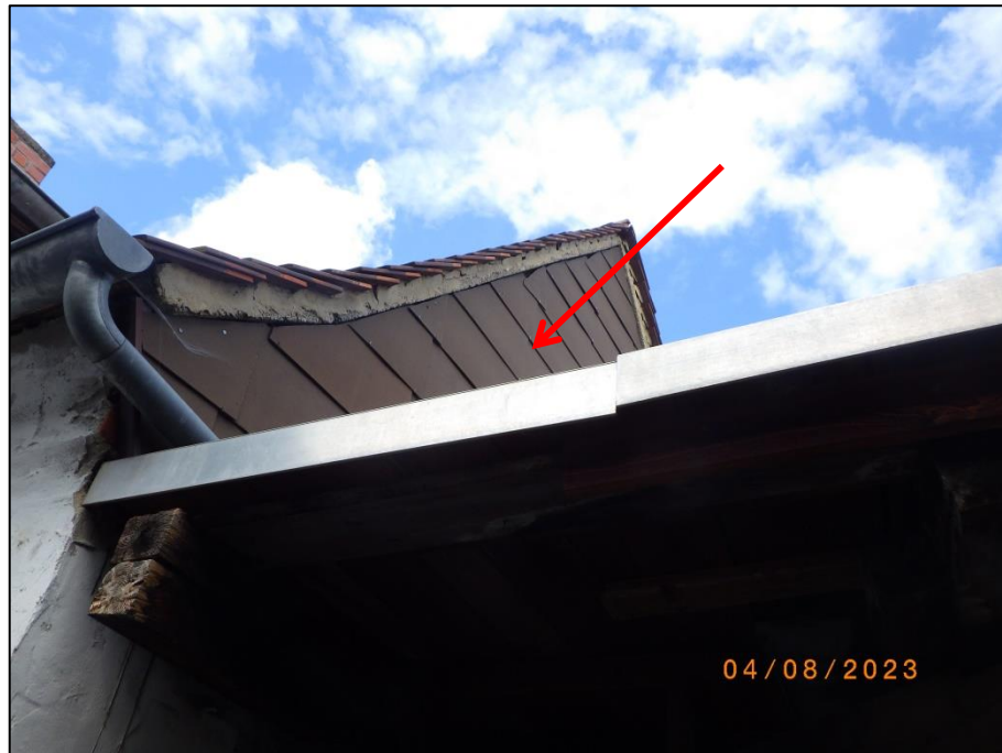
Foto 19 Büro (37/13): Rückseite mit Verblendung aus Asbestzement
