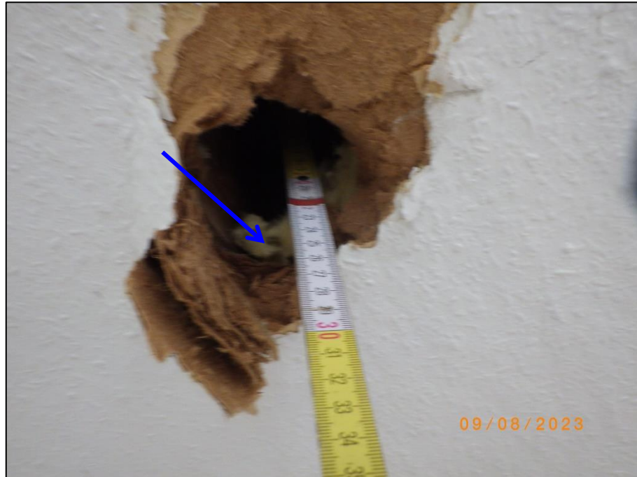
Foto 33 Werkstatt (37/11), Anbau im OG: KMF-Deckendämmung , exemplarisch
