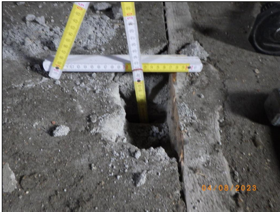
Foto 17 Büro (37/13), Spitzboden: Fußbodenaufbau
