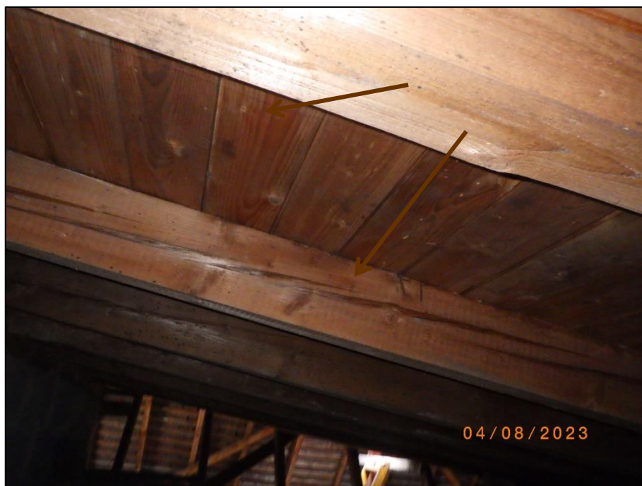
Foto 12 Zwischenbau (37/12), DG: A IV Holz Dachbalken und Bretter
