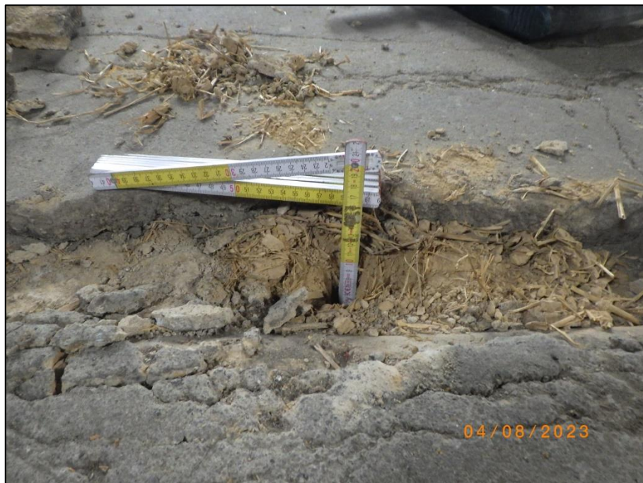
Foto 7 Wohngebäude (37/1), Spitzboden: Fußbodenaufbau (KB 11)
