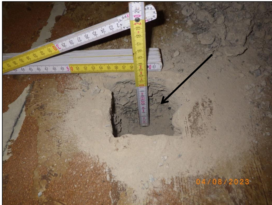
Foto 11 Zwischenbau (37/12), OG: Fußbodenaufbau (KB 4) mit Heraklith
