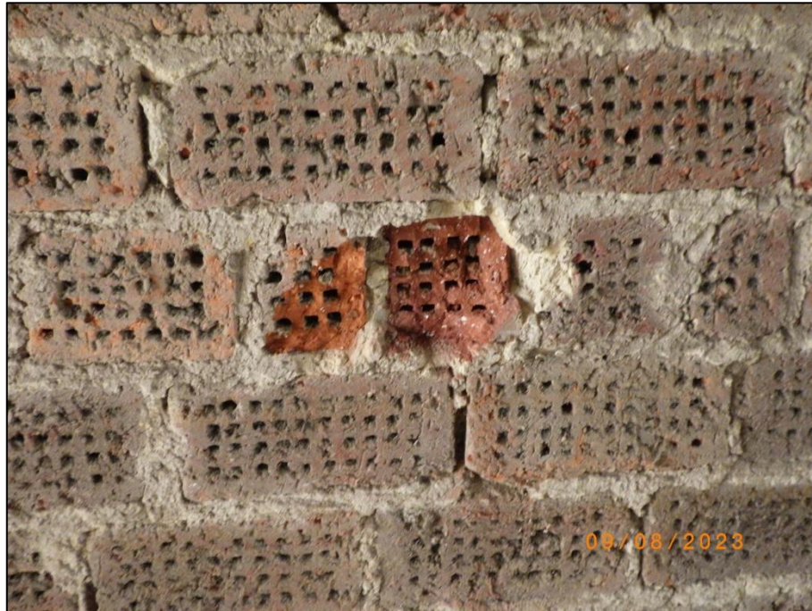
Foto 41 Werkstatt (37/7 + 9 + 10): Hohlziegelmauerwerk (P 24.3)
