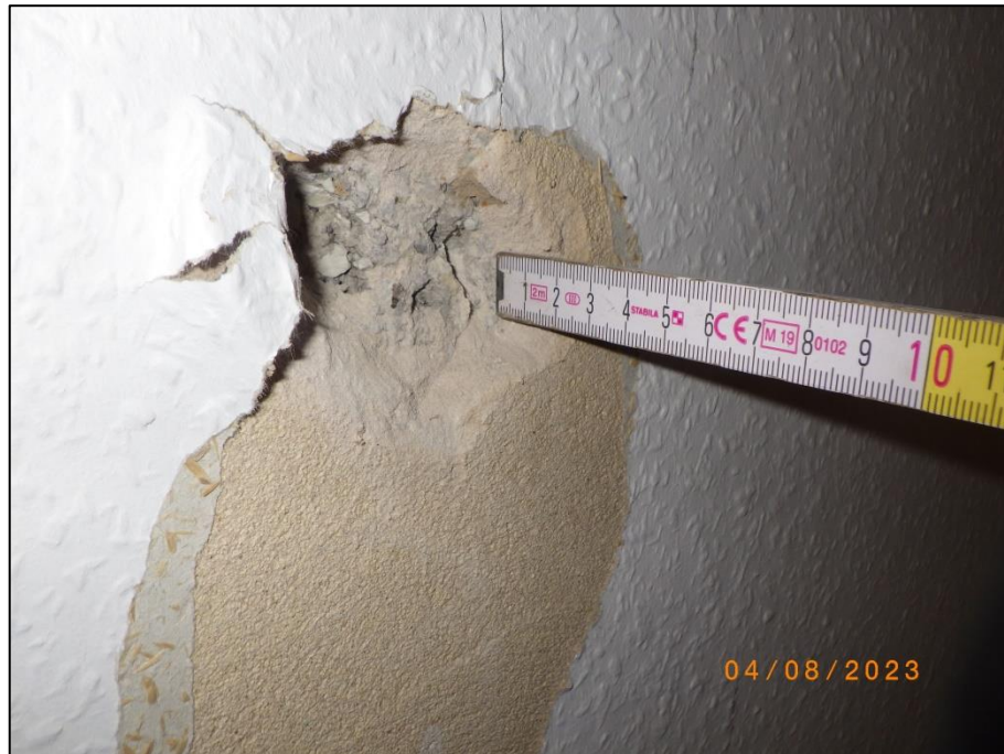
Foto 15 Büro (37/13), EG: Wandaufbau mit Putz (P 9)
