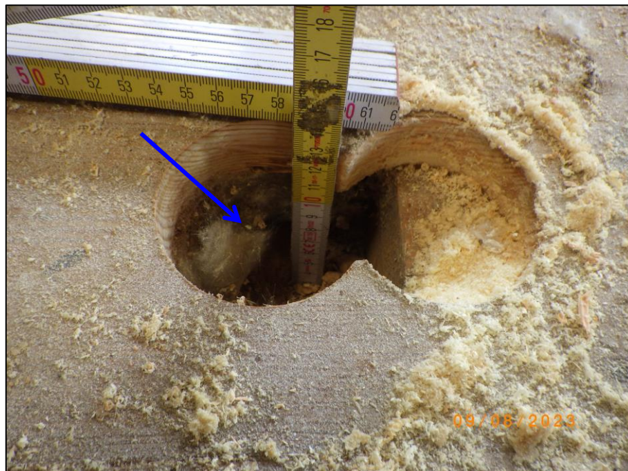
Foto 28 Werkstatt (37/10), EG: Fußbodenaufbau (KB 9) mit KMF-Dämmung (P 17) , exemplarisch
