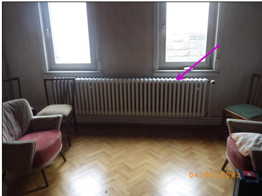
Foto 2 Wohngebäude (37/1), EG: Hinweis auf asbesthaltige Flanschdichtungen in Rippenheizkörpern (EG/OG)
