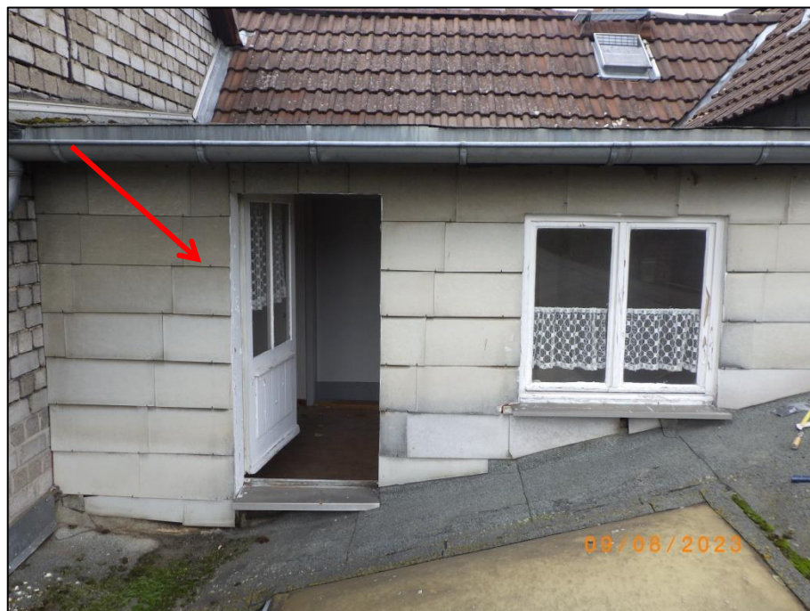
Foto 34 Werkstatt (37/11), Anbau im OG: AZ-Verblendung , exemplarisch
