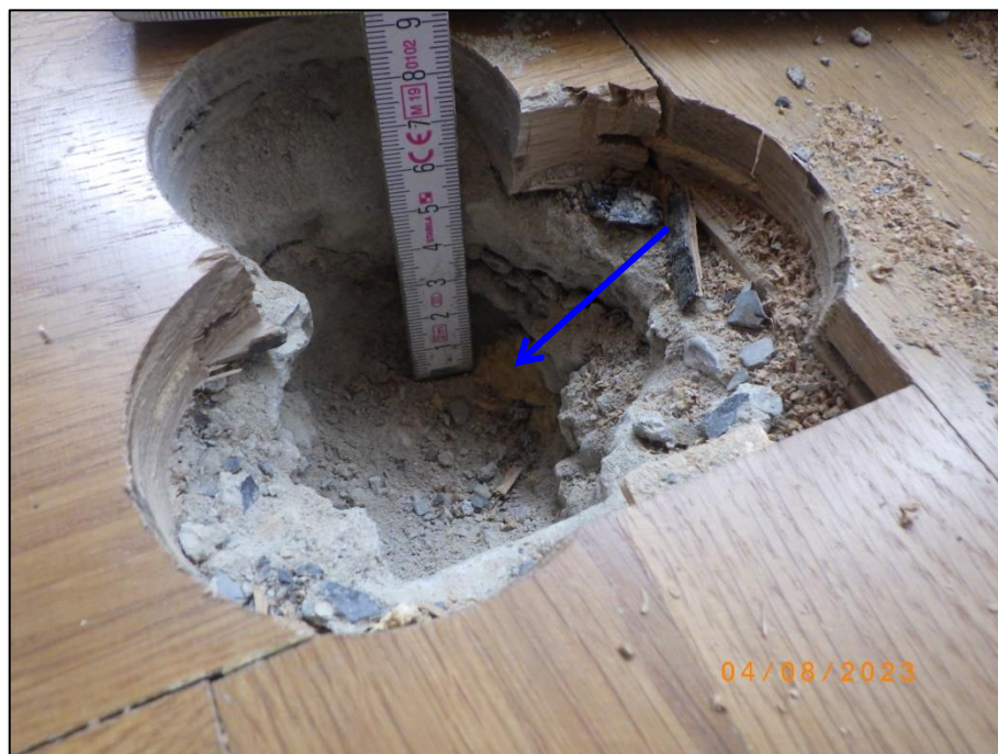
Foto 10 Zwischenbau (37/12), EG: Fußbodenaufbau (KB 2) mit Bitumenlage (P 2) und KMF-Dämmung (P 3), exemplarisch
