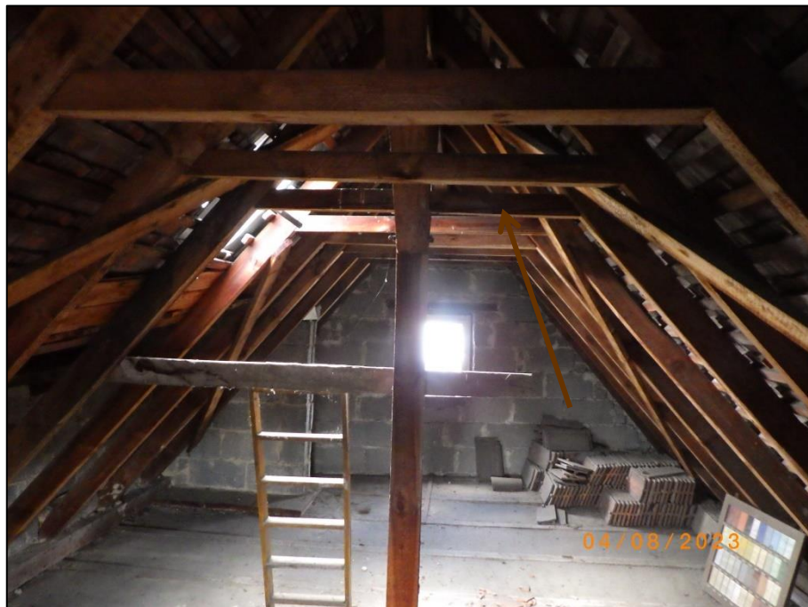
Foto 18 Büro (37/13): Dachaufbau mit A IV Holz Dachbalken
