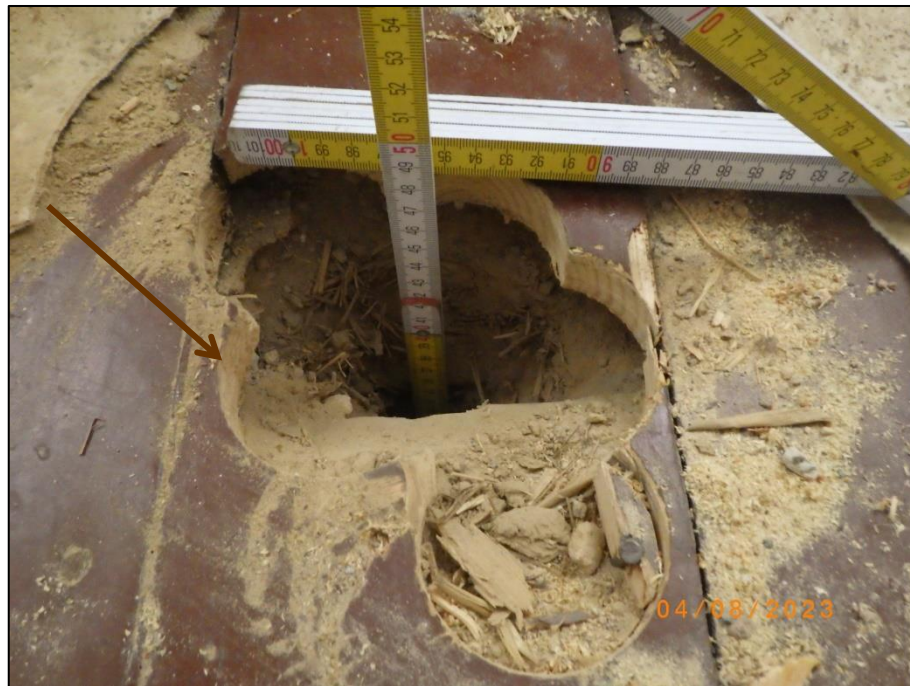
Foto 5 Wohngebäude (37/1), OG: Fußbodenaufbau (KB 3) mit A VI Holz Dielen
