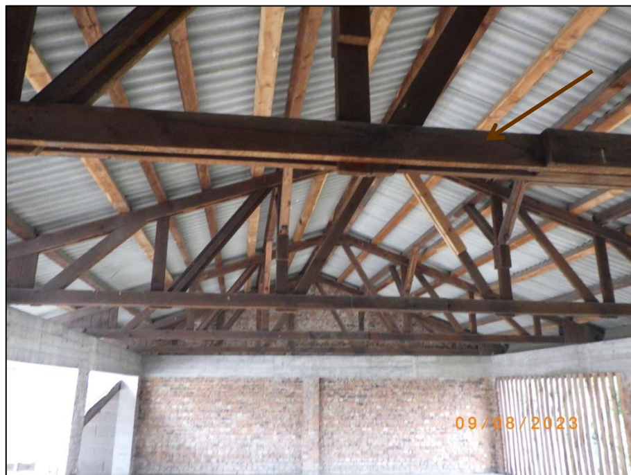
Foto 38 Gebäude 600, OG (KB 9): Dachaufbau mit A IV Holz Dachträgern (P 23), exemplarisch
