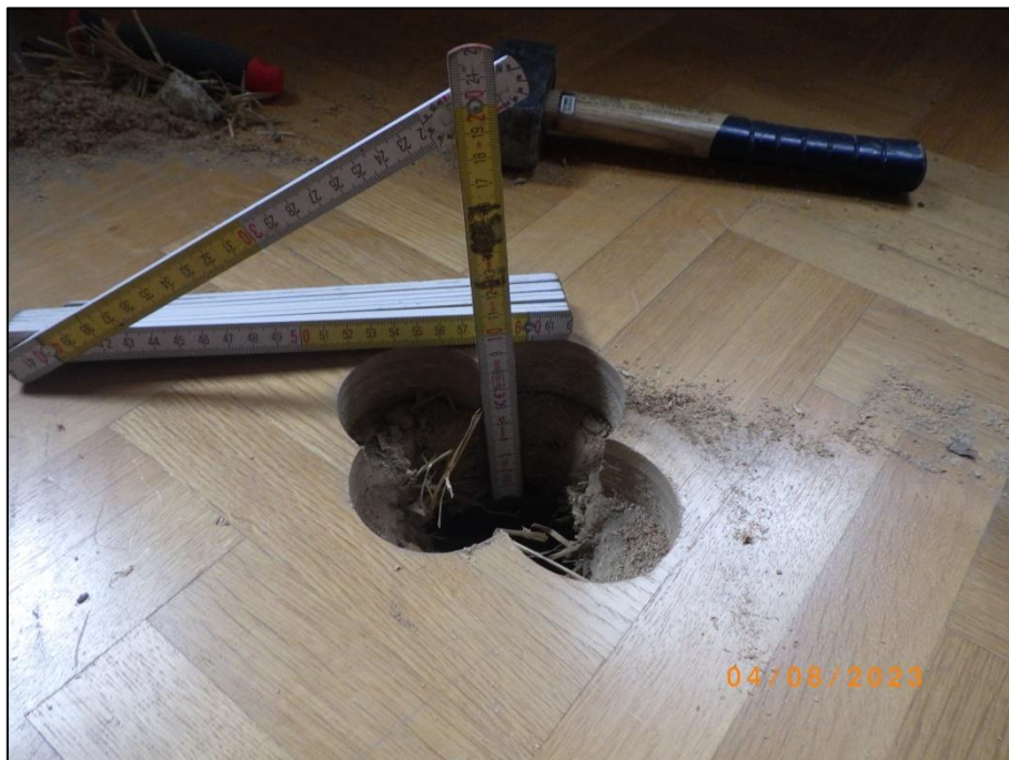
Foto 4 Wohngebäude (37/1), EG: Fußbodenaufbau KB 1
