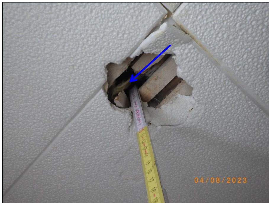
Foto 9 Wohnhaus (37/1), OG (kleiner Anbau): Deckenaufbau mit Styroporverkleidung und KMF-Dämmung (P 8), exemplarisch
