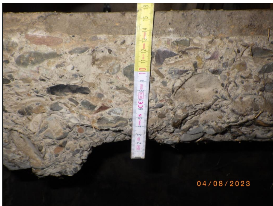
Foto 14 Büro (37/13), EG: Fußbodenaufbau
