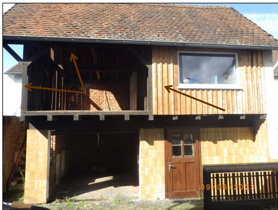
Foto 20 Außenansicht Garage (37/2): mit A IV Holz Balken und Holzwand
