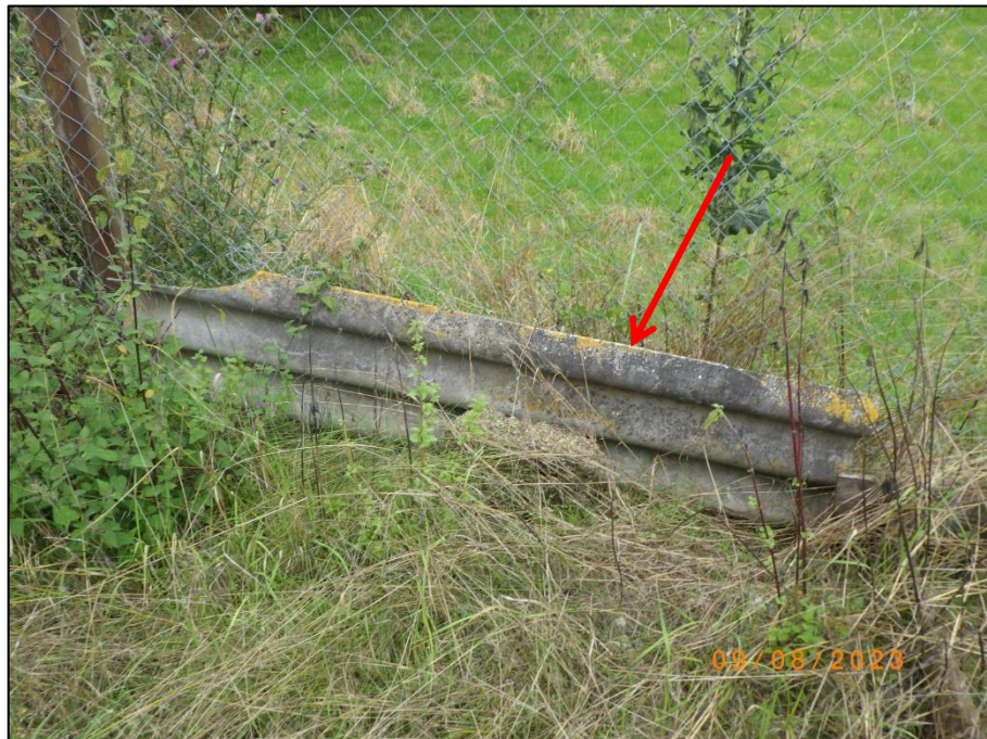
Foto 40 Außenbereich: AZ-Wellplatten , exemplarisch
