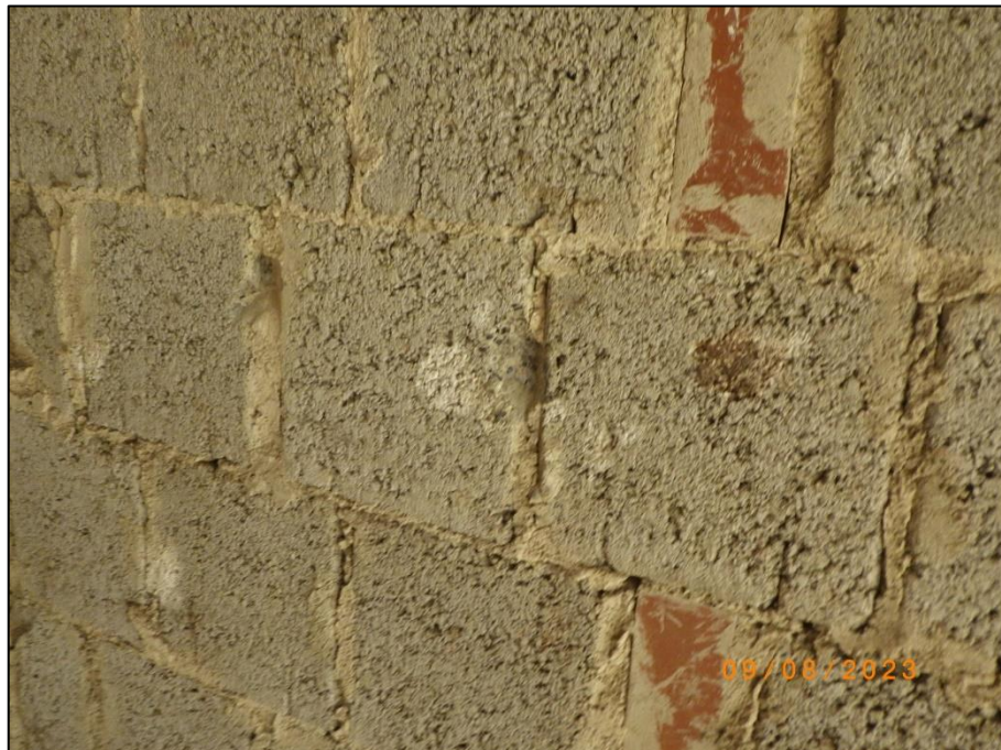
Foto 42 Werkstatt (37/7 + 9 + 10): Betonmauerwerk (P 24.2)
