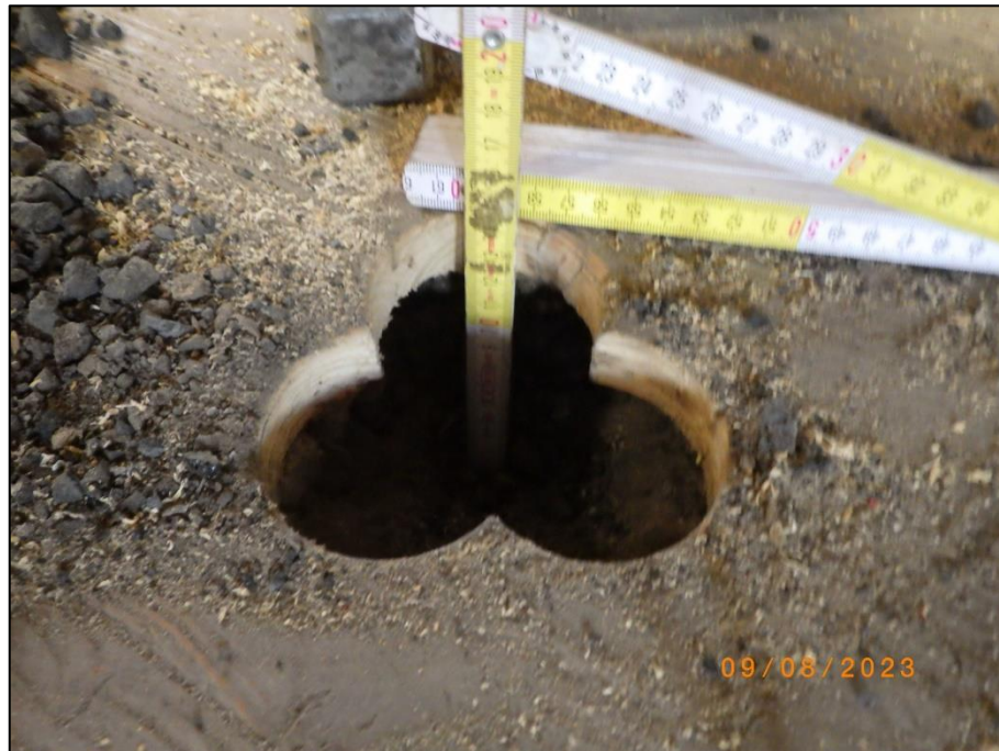
Foto 27 Werkstatt (37/11), EG : Fußbodenaufbau (KB 8)
