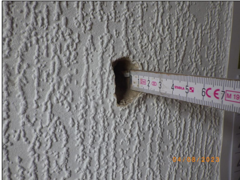
Foto 3 Wohngebäude (37/1), EG: Wandaufbau mit Putz (P 1)
