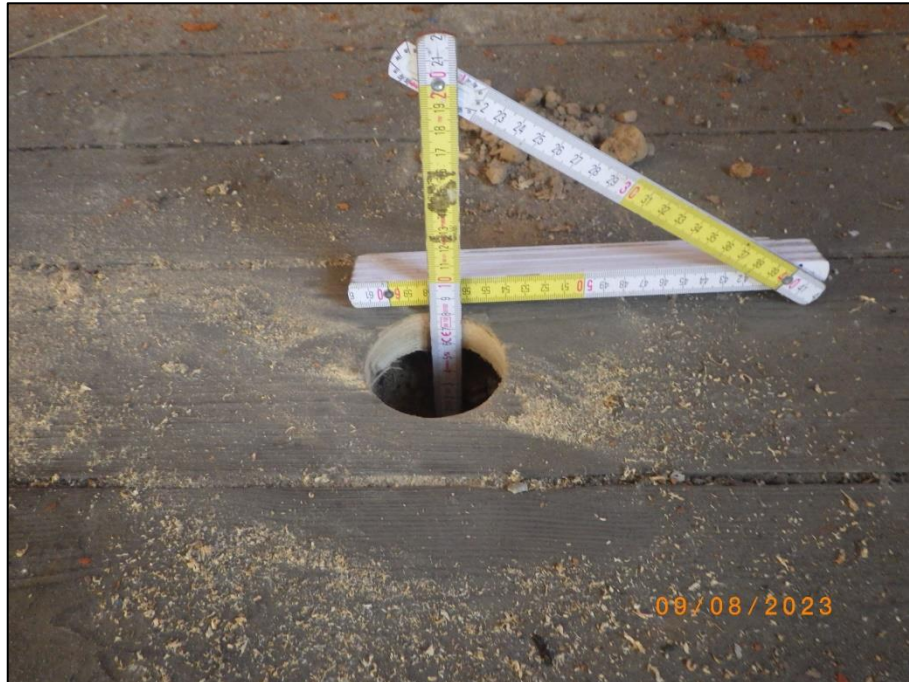
Foto 21 Garage (37/2), OG: Fußbodenaufbau (KB 7)
