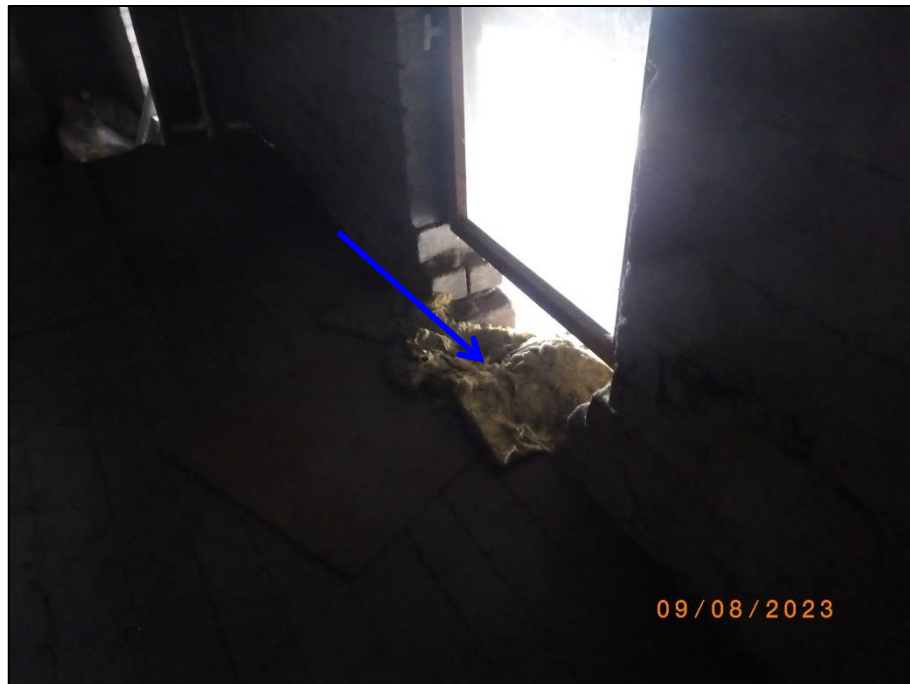
Foto 25 Scheune (37/4 + 5): KMF-Stopfmasse (exemplarisch)
