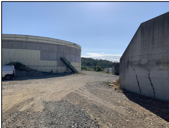
Abb. 6: Behälter und Wand der ehemaligen Fahrhilos mit Schotter- und Rohbodenflächen im Betriebsgelände (eigene Aufnahme, 06.08.2026)
