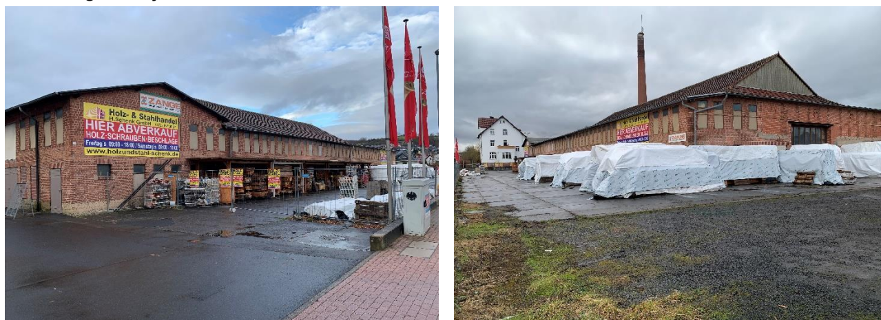
Abbildung 1: Objektsituation auf dem Planareal in der Schlitzer Straße 38 in Niederaula
