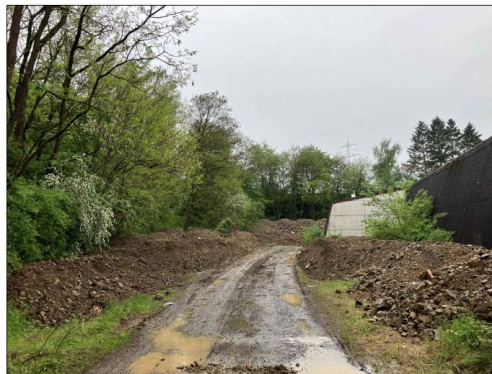
Abb. 4: südwestlicher Bereich der Tennishalle
