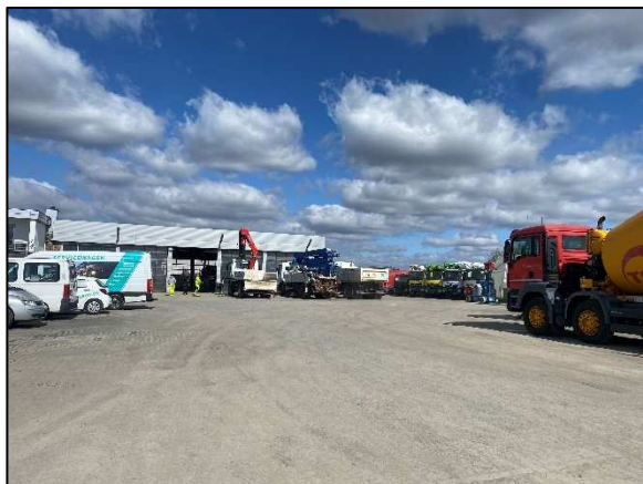
Abb. 6: Bürogebäude und asphaltierte Bereiche im Zentrum des Plangebietes. (eig. Aufnahme 31.03.2025).
