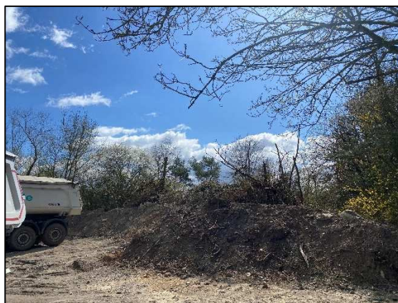
Abb. 9: Erdablagerungen mit Gehölzsaum im Süden des Plangebiets (eig. Aufnahme 31.03.2025).
